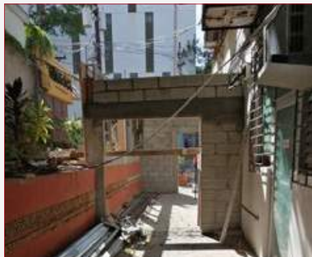
Remodelación de la Biblioteca Zugeidys Ossas, Campus Central
