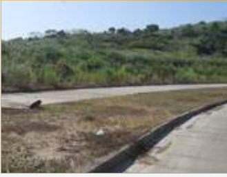
Área física en donde se construirá la nueva Facultad de Enfermería en la Ciudad de la Salud, frente al Hospital
