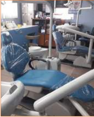
Nuevo equipo dental debidamente instalado
