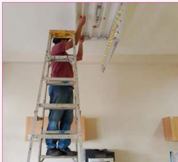
Cambio de tubos de luz
