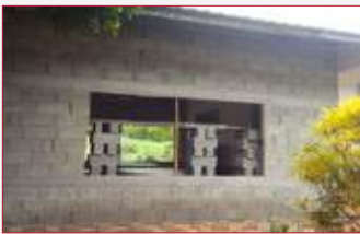
Ampliación de la cafetería
