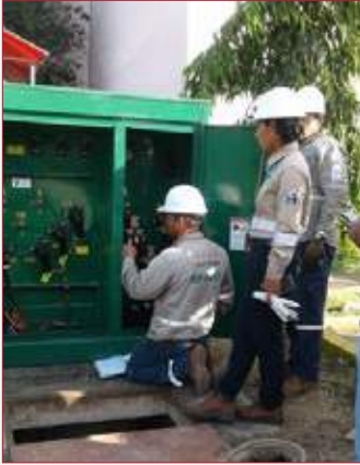
Remplazo del transformador y panel de alta tensión del sistema eléctrico
