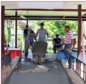
Construcción de rampa en la entrada de la Cafetería Universitaria
