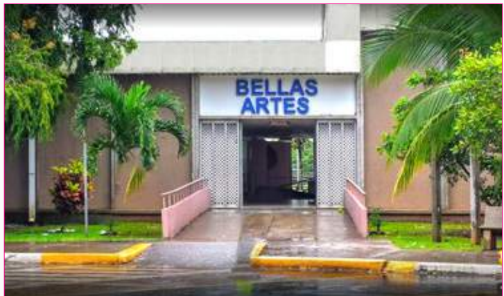
Fachada de la Facultad de Bellas Artes
